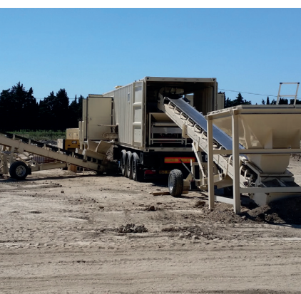
► Exemple de l'utilisation d'un four micro-onde dans une remorque sur chantier pour le traitement des terres (destruction de germes de plantes invasives)
