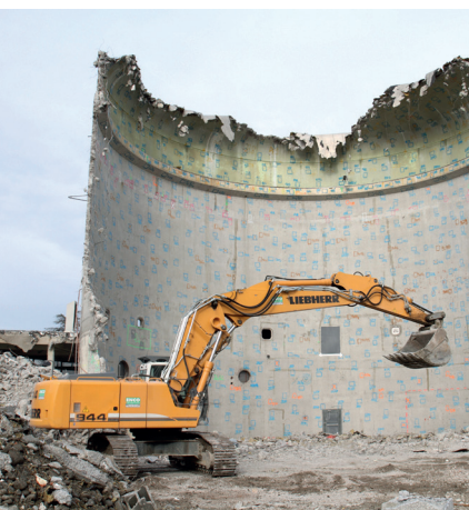
► Démantèlement du réacteur Siloé sur le centre CEA de Grenoble
