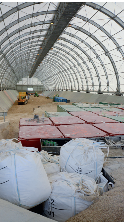
► Stockage de déchets de très faible activité (TFA) dans une alvéole de stockage du Centre industriel de regroupement, d'entreposage et de stockage (Cires)
