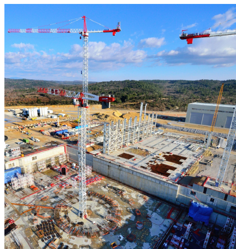
► Chantier de construction d'Iter.
