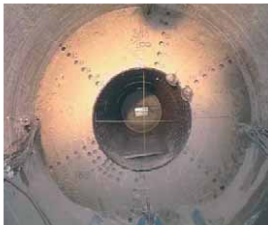
b/ Après resaturation de l'ouvrage, les joints entre briques ne sont plus apparents du fait du gonflement de la barrière ouvragée
