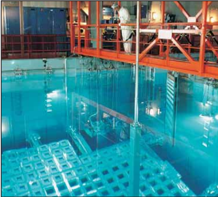
Piscine de refroidissement de combustibles usés
