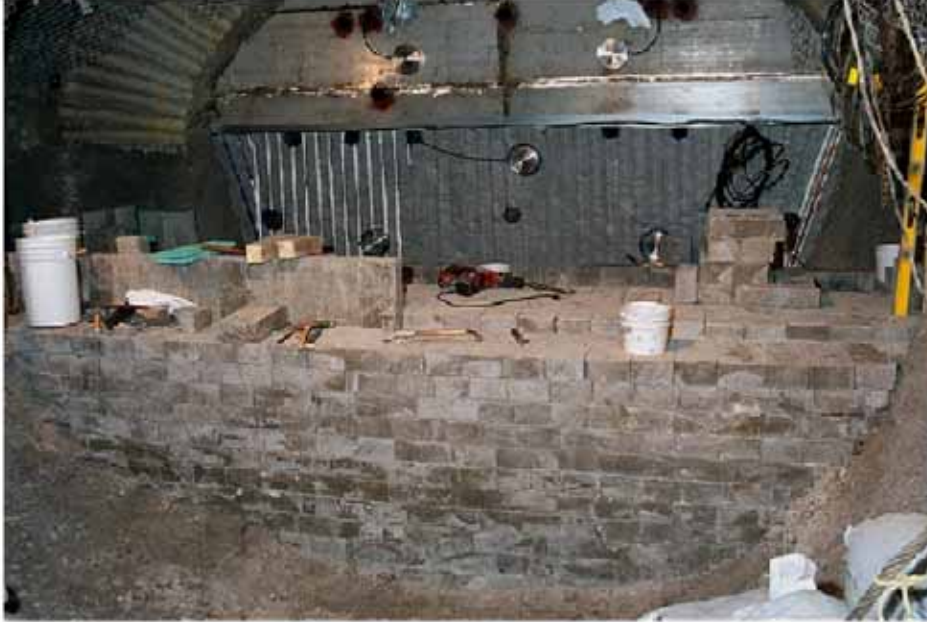
Figure 6.2-22 Scellement expérimental constitué de briques de bentonite – essai TSX mené au Canada (à l'échelle industrielles, ces briques seraient de dimensions supérieures)
