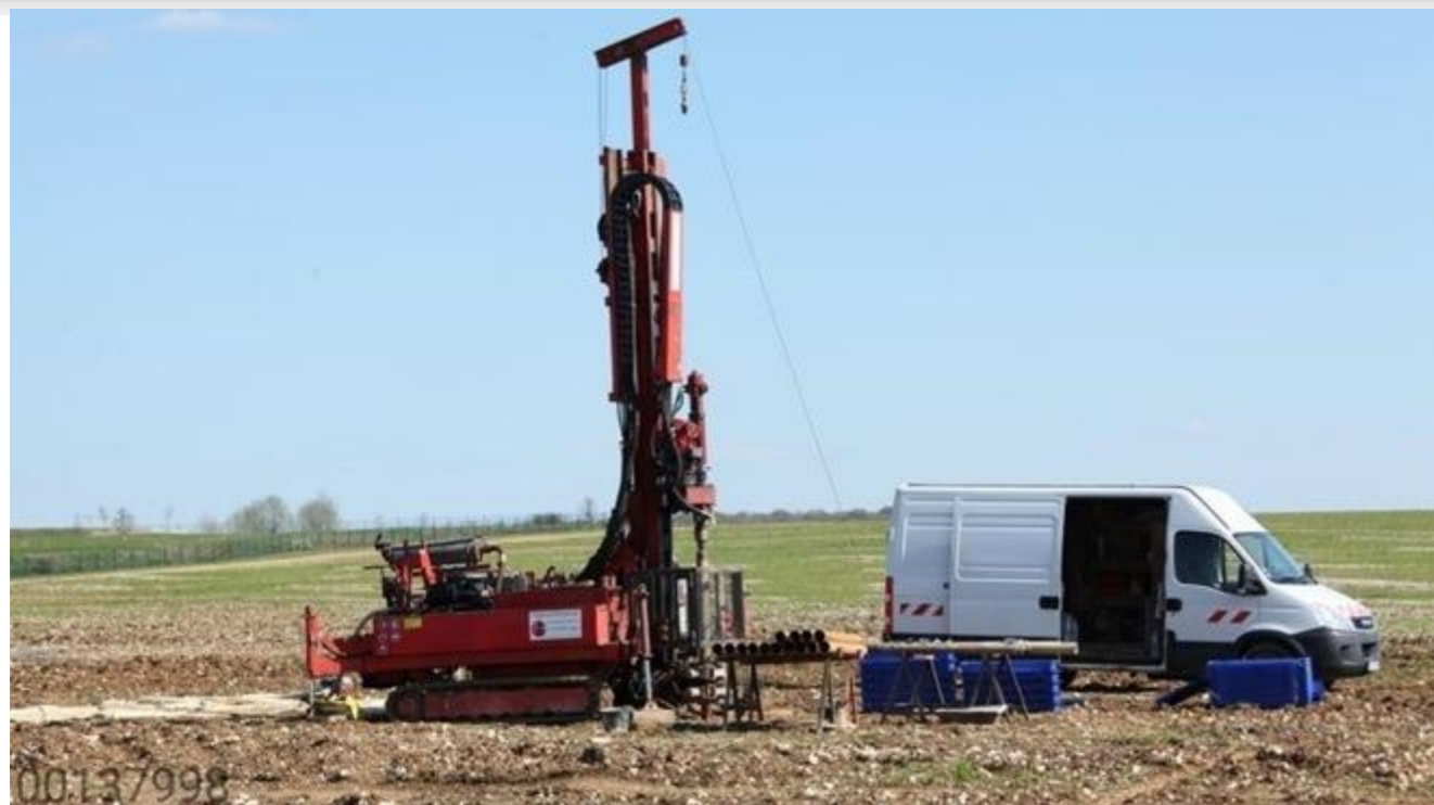
Figure 4-9 Vue sur un sondage carotté
