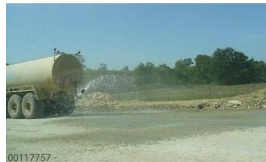
Figure 4-8 Exemple d'arrosage des pistes de chantier (source : Egis)
