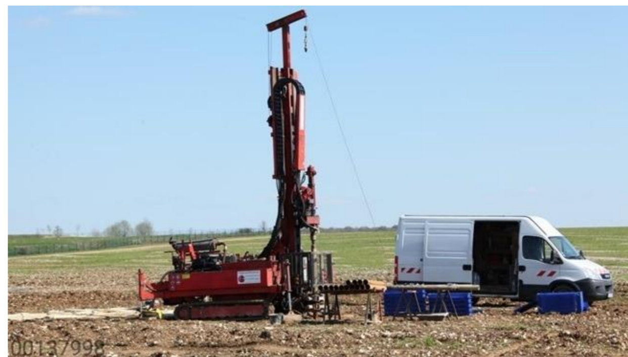
Figure 2-10 Exemple de sondage carotté (source : Egis)
