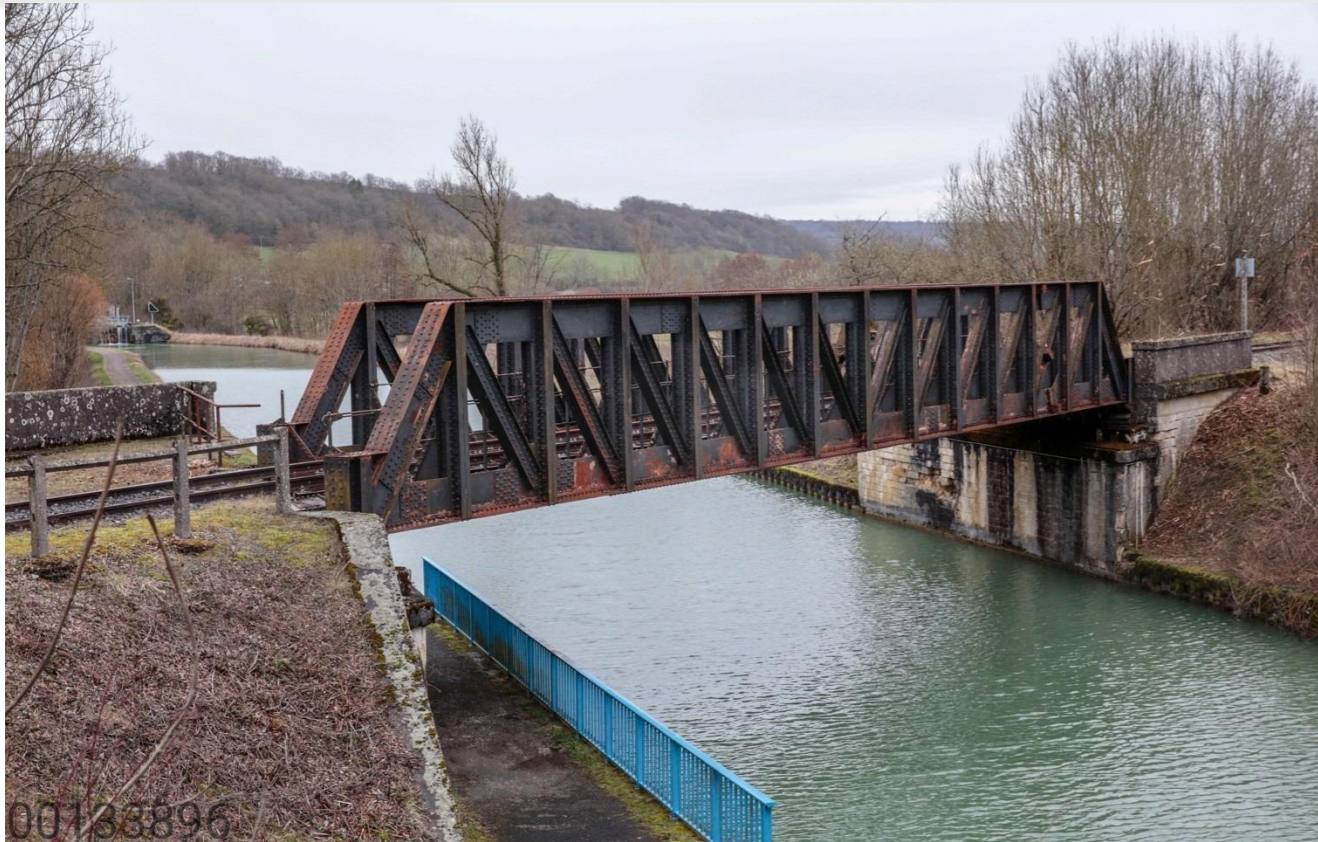
Figure 14-32 La voie ferrée 027000 chevauchant le canal de la Marne au Rhin [19] - 16/02/2021
