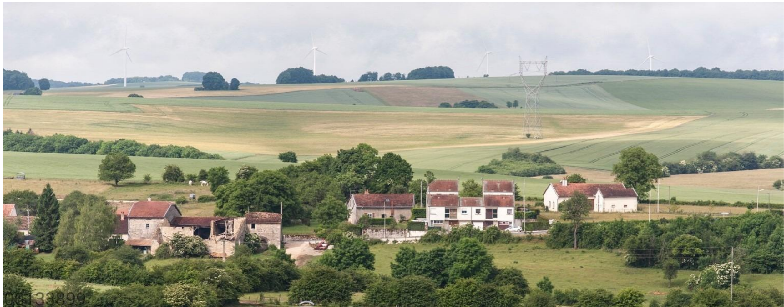
Figure 14-65 Parc éolien et lignes H.T. présents au sein du périmètre rapproché (point de vue 46) - 16/02/2021
