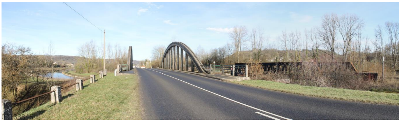
Figure 14-27 Menaucourt - Route départementale D966 et ligne ferroviaire 027000 qui enjambent le canal de la Marne au Rhin [14] - 16/02/2021
