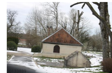
Lavoir sur Cirfontaines
