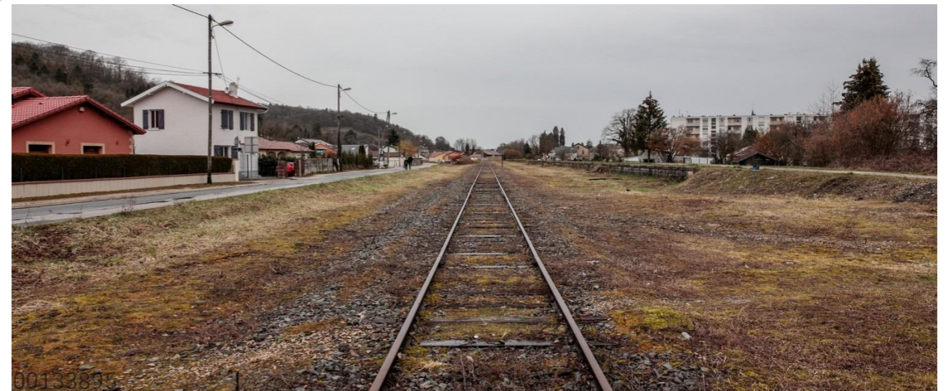
Figure 14-31 La voie ferrée 027000 traversant Ligny-en-Barrois [18] - 16/02/2021
