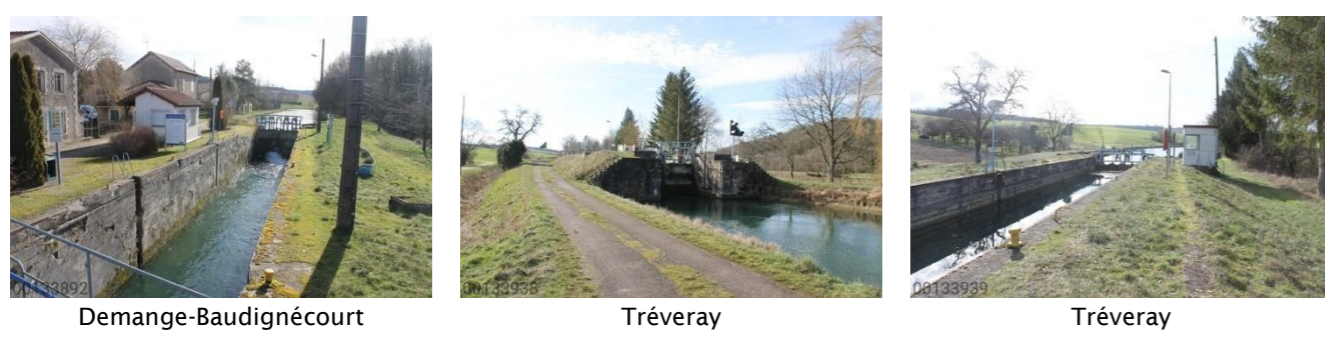
Figure 14-90 Photographies des écluses présentes au sein de l'aire d'étude immédiate - 16/02/2021
