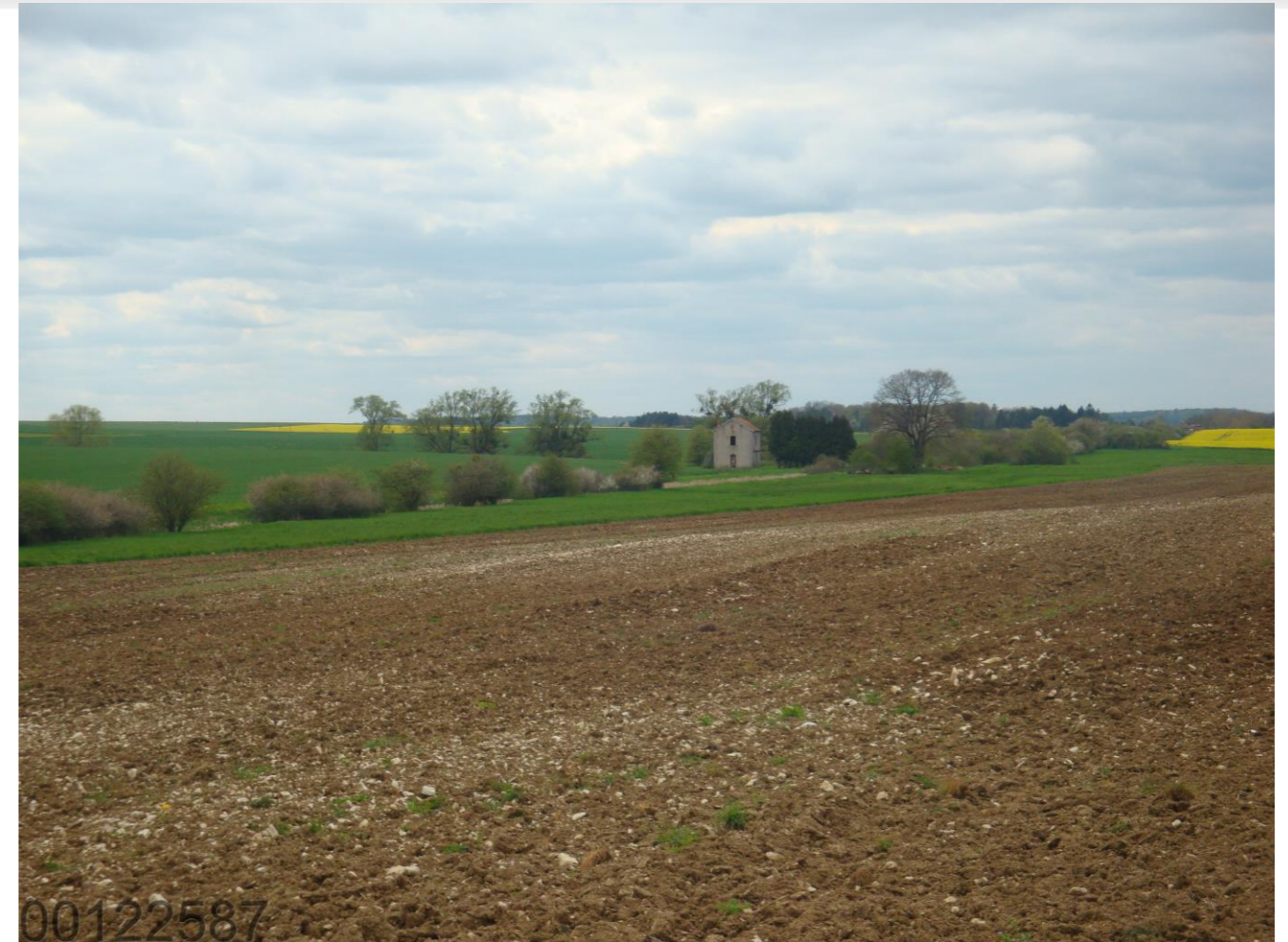
Figure 14-58 Ancienne maison de garde-barrière le long de la voie ferrée, future implantation de l'ITE, incluse dans l'aire d'étude rapprochée du milieu physique [41]
