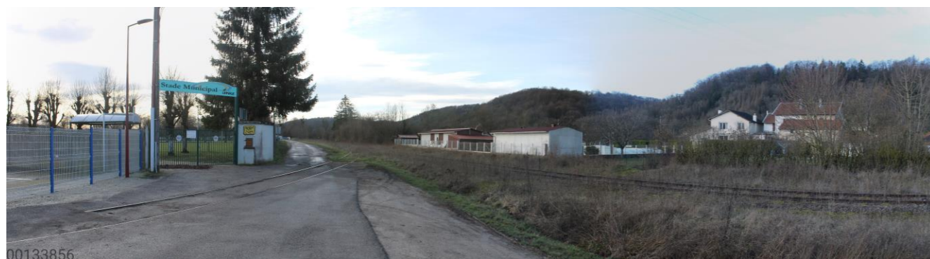
Figure 14-42 Proximité stade municipal de Ligny-en-Barrois [28] - 16/02/2021
