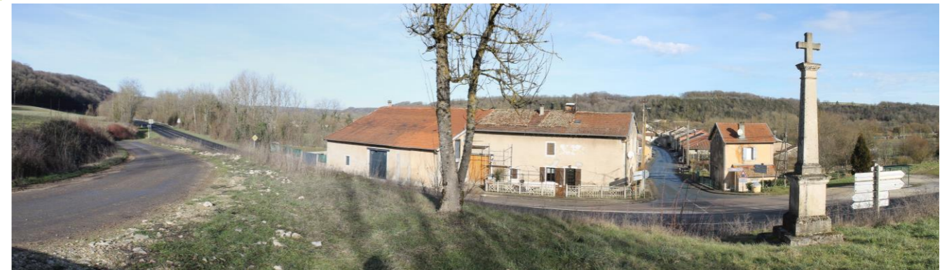
Figure 14-29 Le village de Naix-aux-Forges traversé par la voie ferrée 027000 [16] - 16/02/2021
