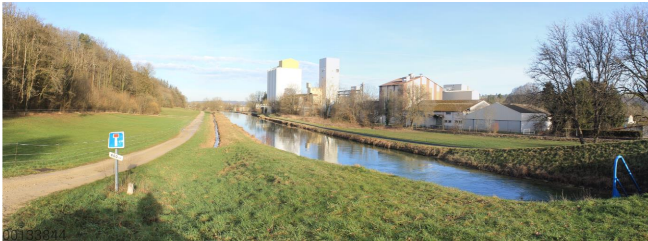
Figure 14-26 Ligny-en-Barrois - Le canal de la Marne au Rhin au premier plan, puis la ligne ferroviaire 027000 [13] - 16/02/2021
