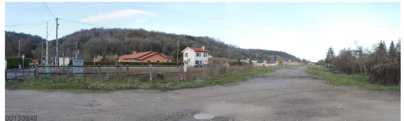
Figure 14-30 La voie ferrée 027000 entre dans la commune de Ligny-en-Barrois [17] - 16/02/2021
