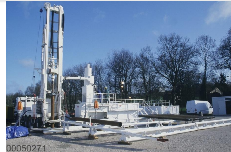
Figure 2-24 Forage de suivi géologique autour du Laboratoire de recherche souterrain de Meuse/Haute-Marne (Démanges aux Eaux)
