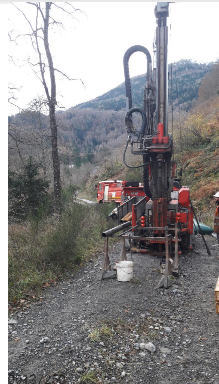
Figure 5-9 Photographie d'un sondage carotté (source : EGIS, projet Pau-Canfranc)
