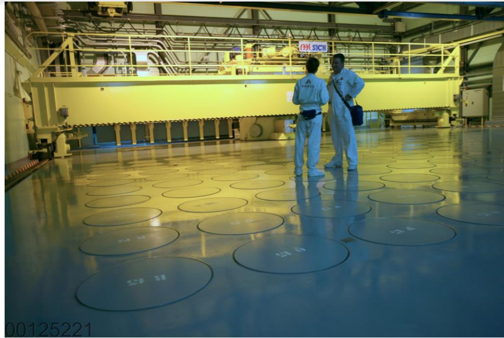
Figure 1-14 Hall d'entreposage de l'atelier de vitrification R7 UP2 800 d'Orano à La Hague © Orano
