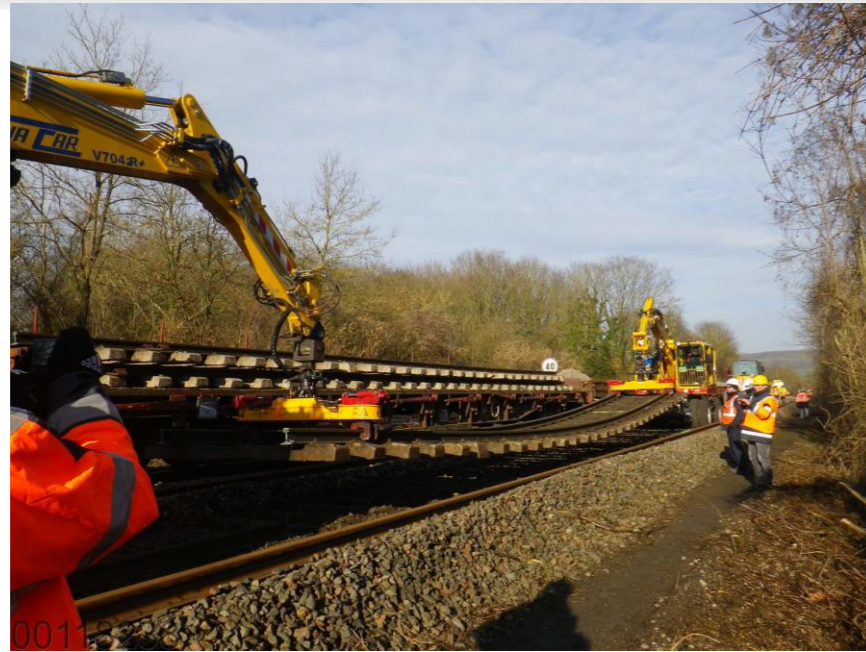
Figure 3-115 Enlèvement de portions d'ancienne voie ferrée
