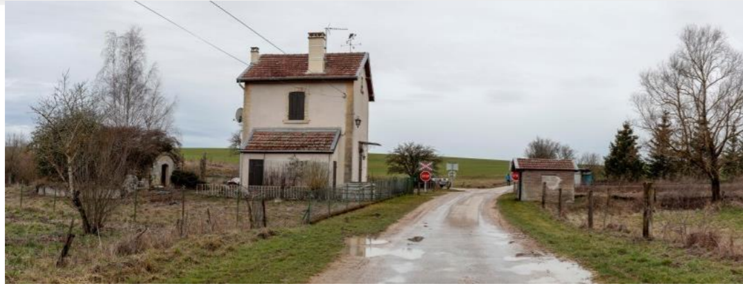
Figure 3-111 Passage à niveau à Abainville
