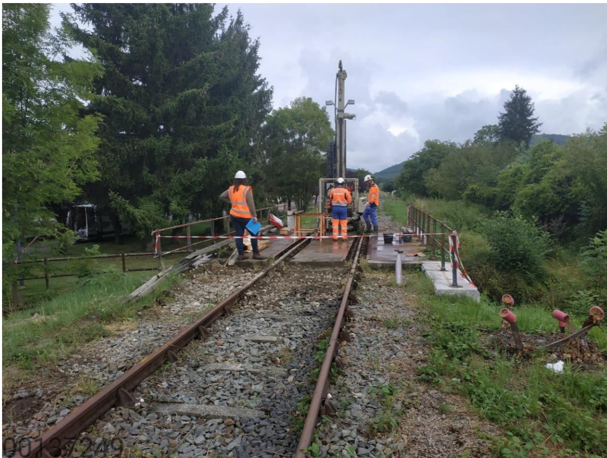
Figure 5-10 Photographie d'un sondage carotté sur ligne ferroviaire
