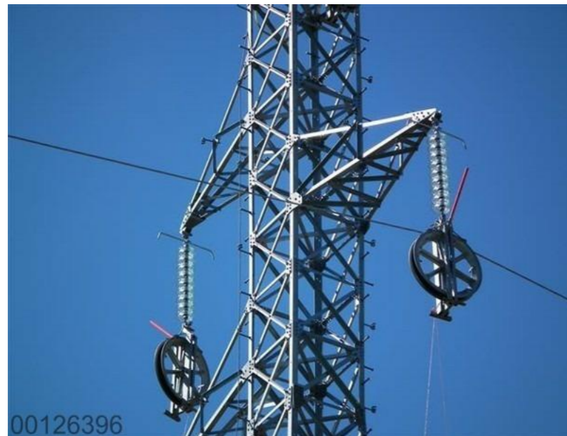
Figure 5-5 Illustration d'une poulie de déroulage (source RTE - juin 2020)
