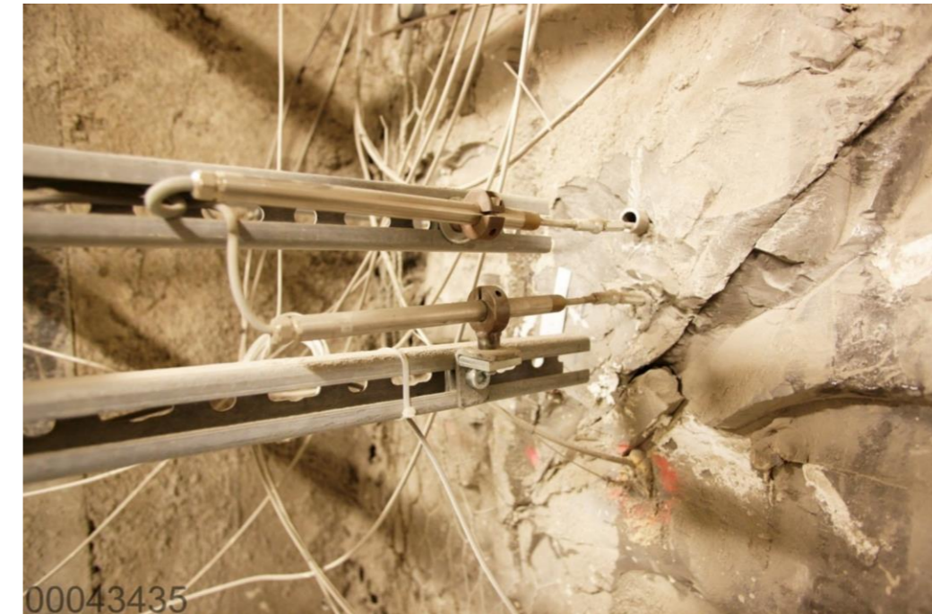
Figure 2-25 Expérimentation de mesures potentiométriques dans le Callovo-Oxfordien (expérimentation TER) dans le Laboratoire de recherche souterrain de Meuse/Haute-Marne
