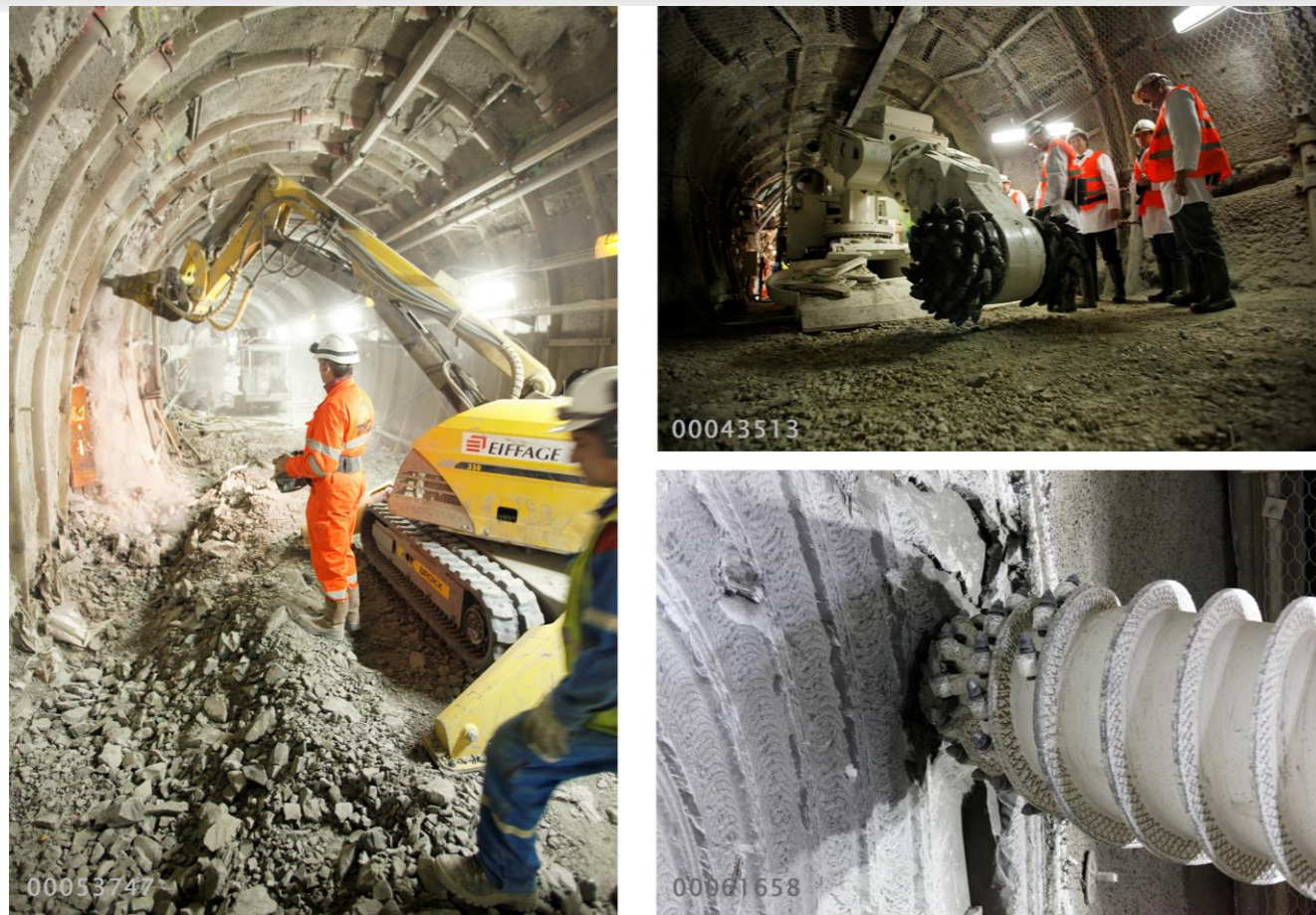
Figure 2-28 Différentes techniques de creusement testées au Laboratoire souterrain : le brise roche hydraulique (à gauche), la machine à attaque ponctuelle (en haut à droite) et la machine à attaque ponctuelle sous jupe avec tunnelier (en bas à droite)
