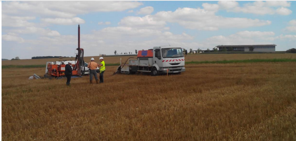
Figure 3-124 Plateforme de forage profond
