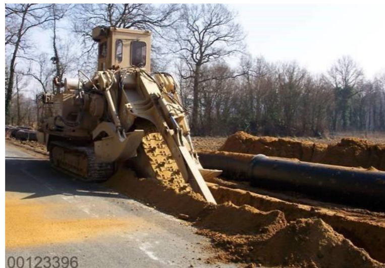
Figure 3-106 Trancheuse pour pose de canalisation
