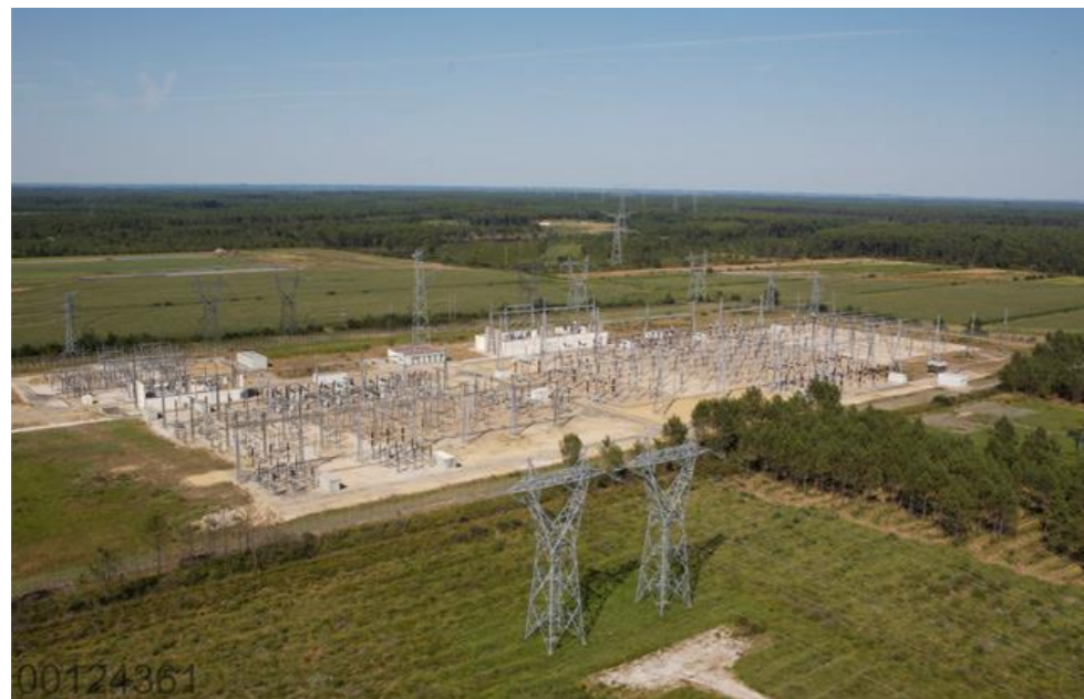
Figure 3-101 Illustration d'un poste de transformation 400/90 kV
