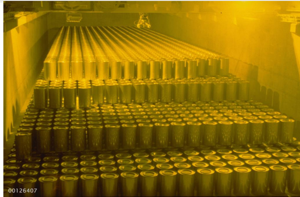
Figure 1-15 Exemple d'installation d'entreposage de déchets MA-VL : installation STE3 du site Orano de La Hague (photo prise à travers un hublot de protection) © Orano
