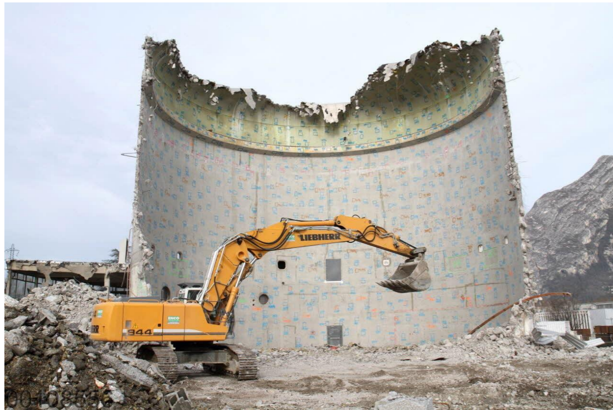
Figure 5-11 Photographie d'opération de démolition
