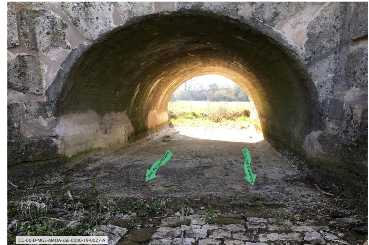
Figure 5-57 Vue du radier à sec au passage de la Bureau sous la route départementale D 127 (Andra, avril 2019)
