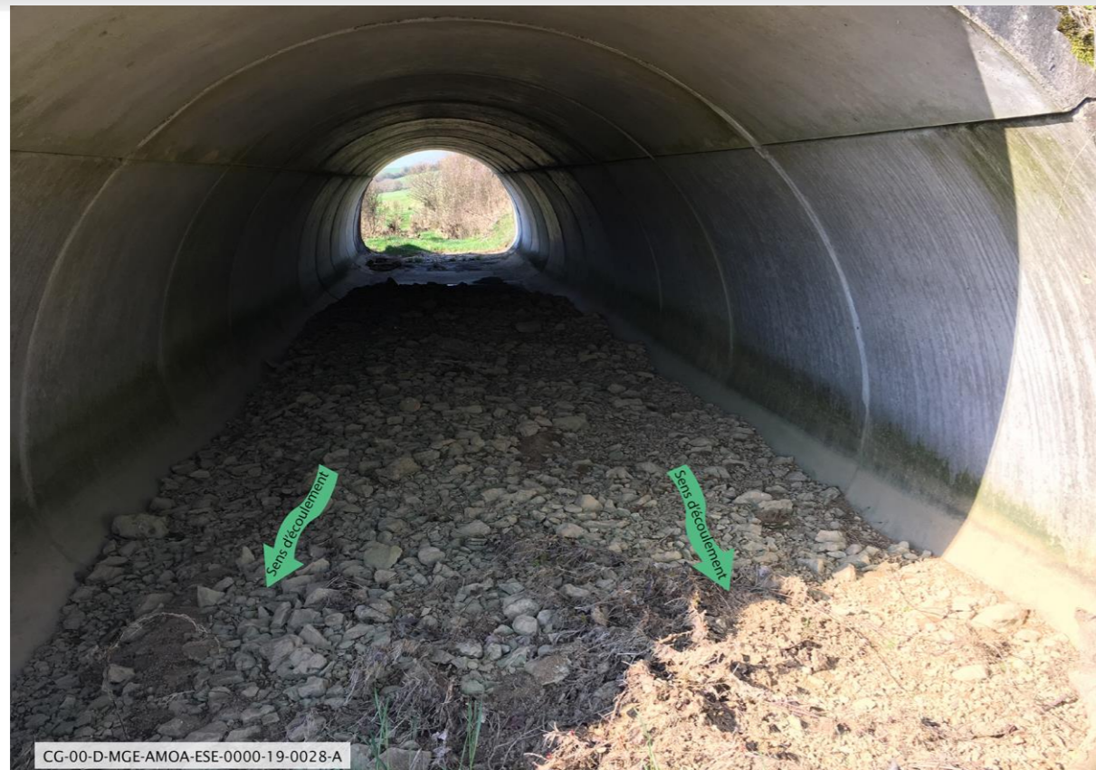
Figure 5-58 Vue de l'accumulation de blocs calcaires charriés sur le radier à sec au passage de la Bureau sous la route départementale D 132 (Andra, avril 2019)
