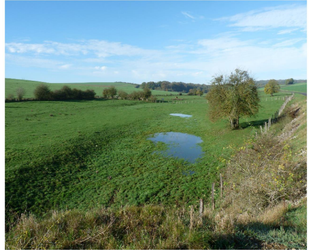
L'Orge au droit du franchissement de la RD132 en période de basses eaux (oct. 2017)
