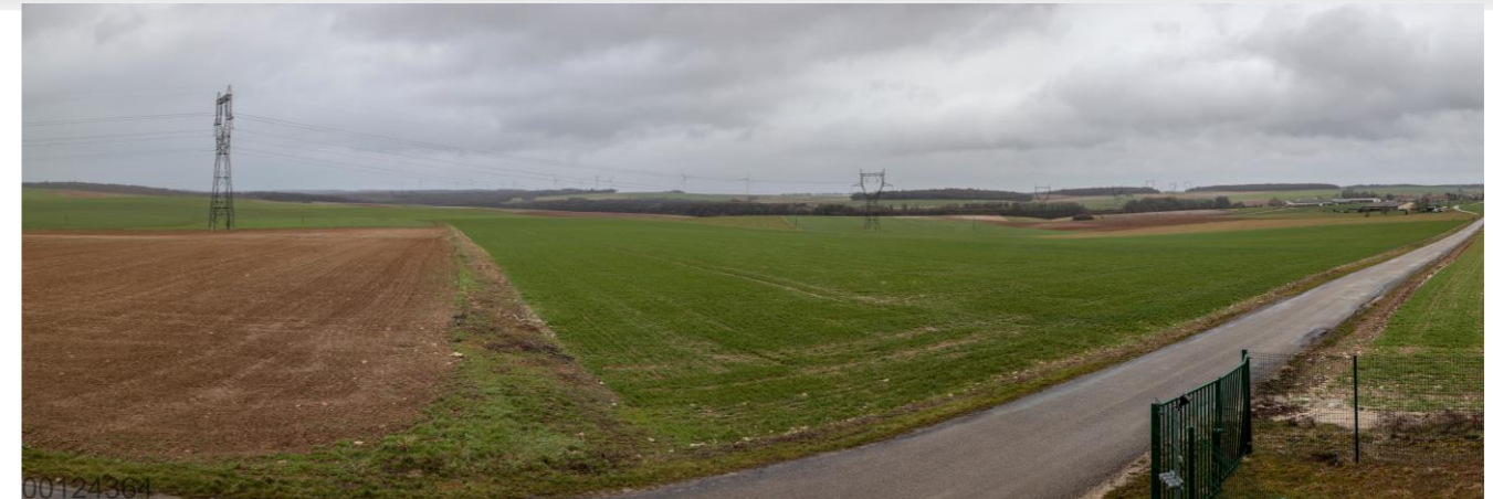
Figure 9-3 Vue de la ligne électrique très haute tension 400 kV Houdreville-Méry
