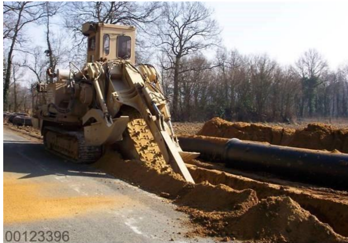
Figure 5-18 Trancheuse pour pose de canalisation
