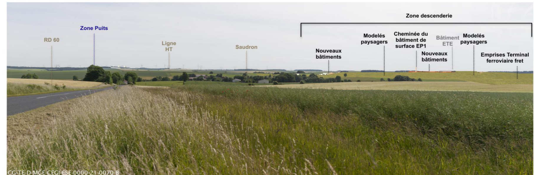
Figure 14-38 Incidences potentielles en phase de construction initiale depuis le point de vue 22b
