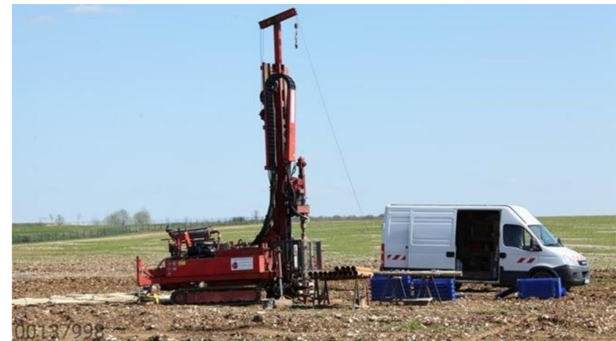
Figure 14-104 Exemple de foreuse lors d'investigations géotechniques (source ANDRA)
