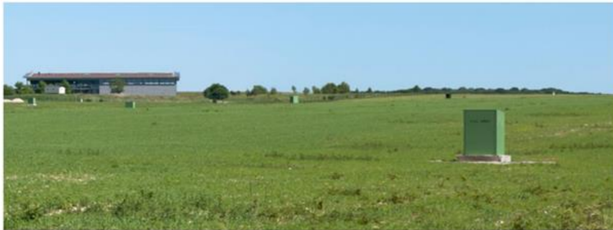
Figure 14-100 Exemple d'aménagement de surface en sortie de piézomètre – dalle béton de 2 m x 2 m x 0 m 30 autour d'une tête métallique qui protège le piézomètre – Cabanon de protection fixé sur dalle de 2 m de hauteur environ (Source ANDRA)
