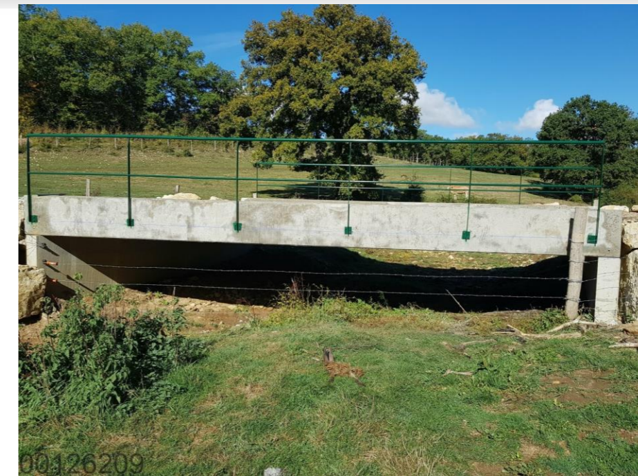
Figure 14-113 Pont aménagé sur l'Ormançon pour faciliter l'accès au bois de la Caisse
