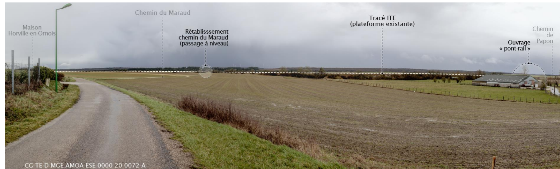
Figure 14-50 Vue 15a – Vue sur l'ITE dans sa partie existante depuis le village d'Horville-en-Ornois (phase APR)
