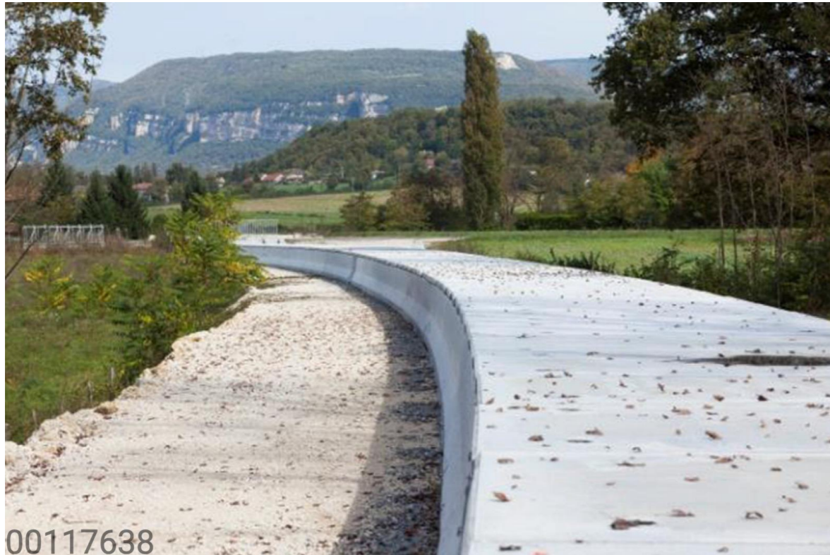
Figure 8-3 Exemple de bande transporteuse semi-enterrée
