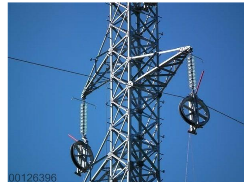
Figure 2-10 Illustration d'une poulie de déroulage (source RTE)
