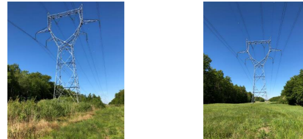
Figure 4-21 Photos des pylônes 107 à gauche et 108 à droite (AdT pour RTE, 2019)
