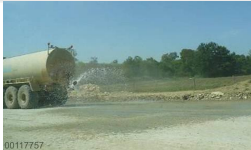
Figure 3-2 Vue de l'arrosage de pistes pour limiter l'envol de poussières par temps sec
