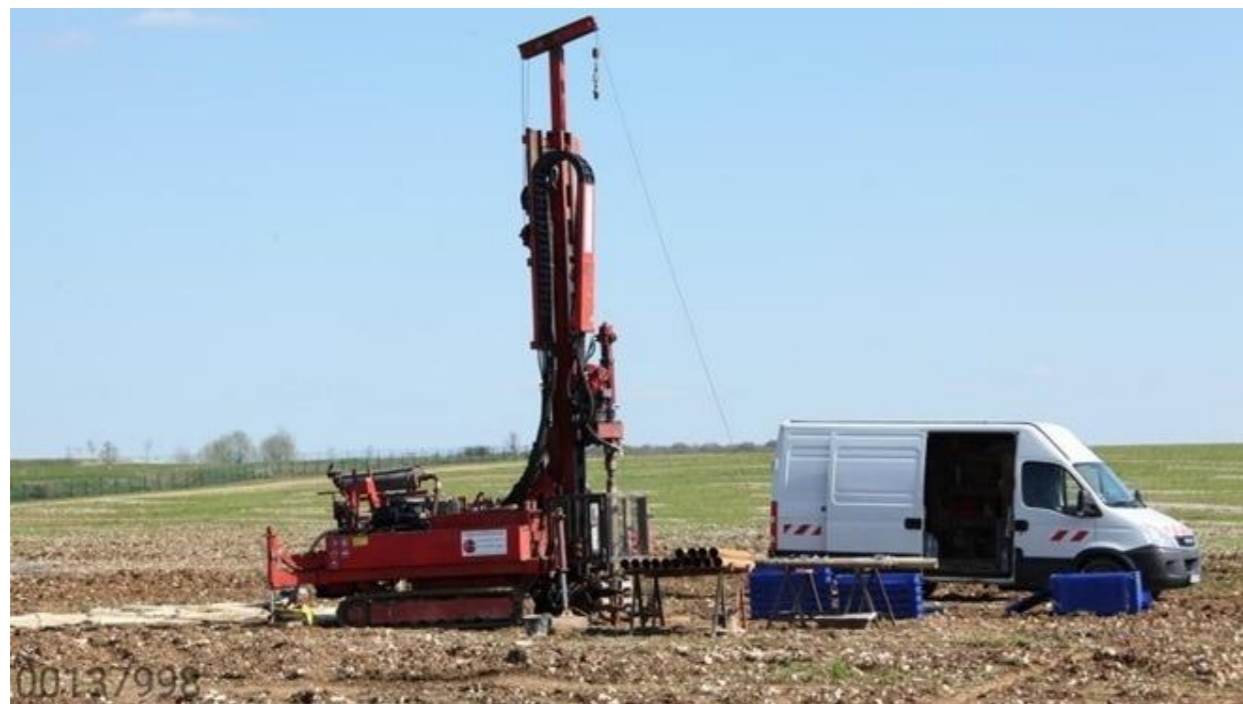
Figure 4-8 Exemple de foreuse lors d'investigations géotechniques. (source Andra)
