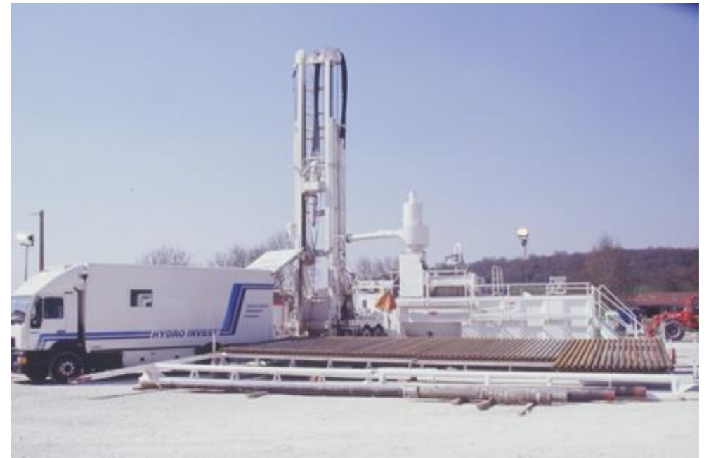
Plateforme de forage profond
