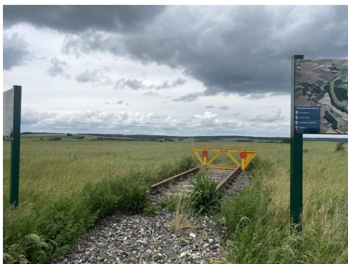
Figure 14 : exemple d'aménagement didactique montrant la future voie de chemin de fer avec à droite un panneau explicatif. Source rapporteurs. Photo des rapporteurs.
